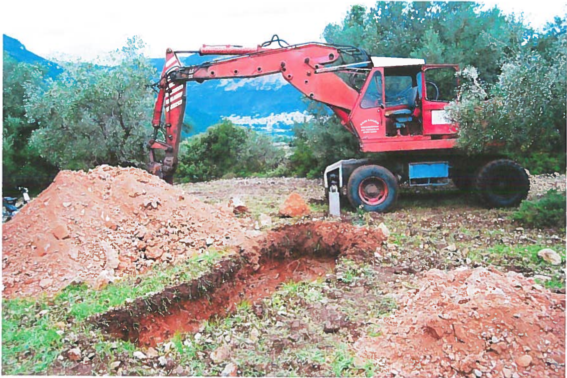
Φωτ.15. Δειγματοληπτικό φρέαρ ΕΦ1. Διακρίνονται στα υλικά εκσκαφής ασβεστολιθικοί ογκόλιθοι.
