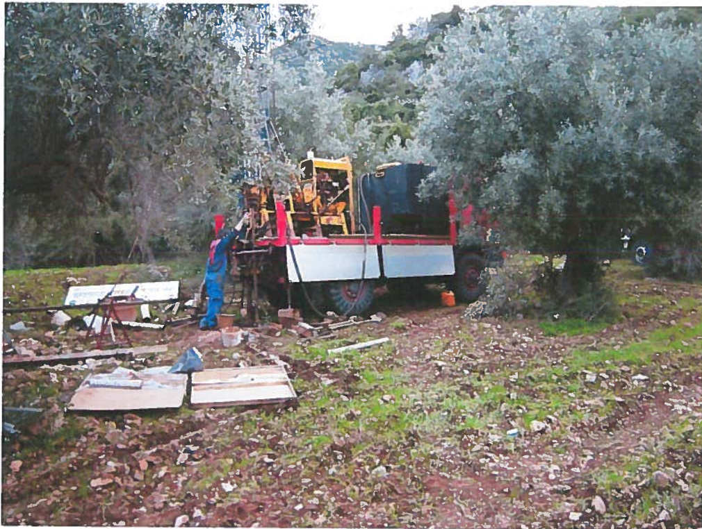
Φωτ.7. Θέση εκτέλεσης δειγματοληπτικής γεώτρησης Γ3.
