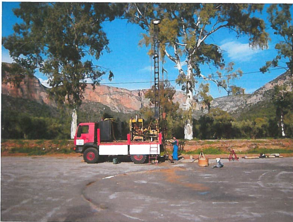
Φωτ.1. Θέση εκτέλεσης δειγματοληπτικής γεώτρησης Γ1.
