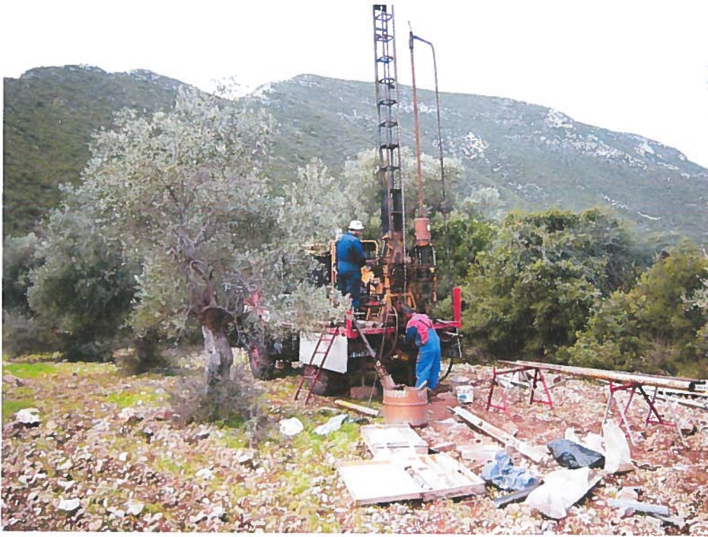
Φωτ.4. Θέση εκτέλεσης δειγματοληπτικής γεώτρησης Γ2.
