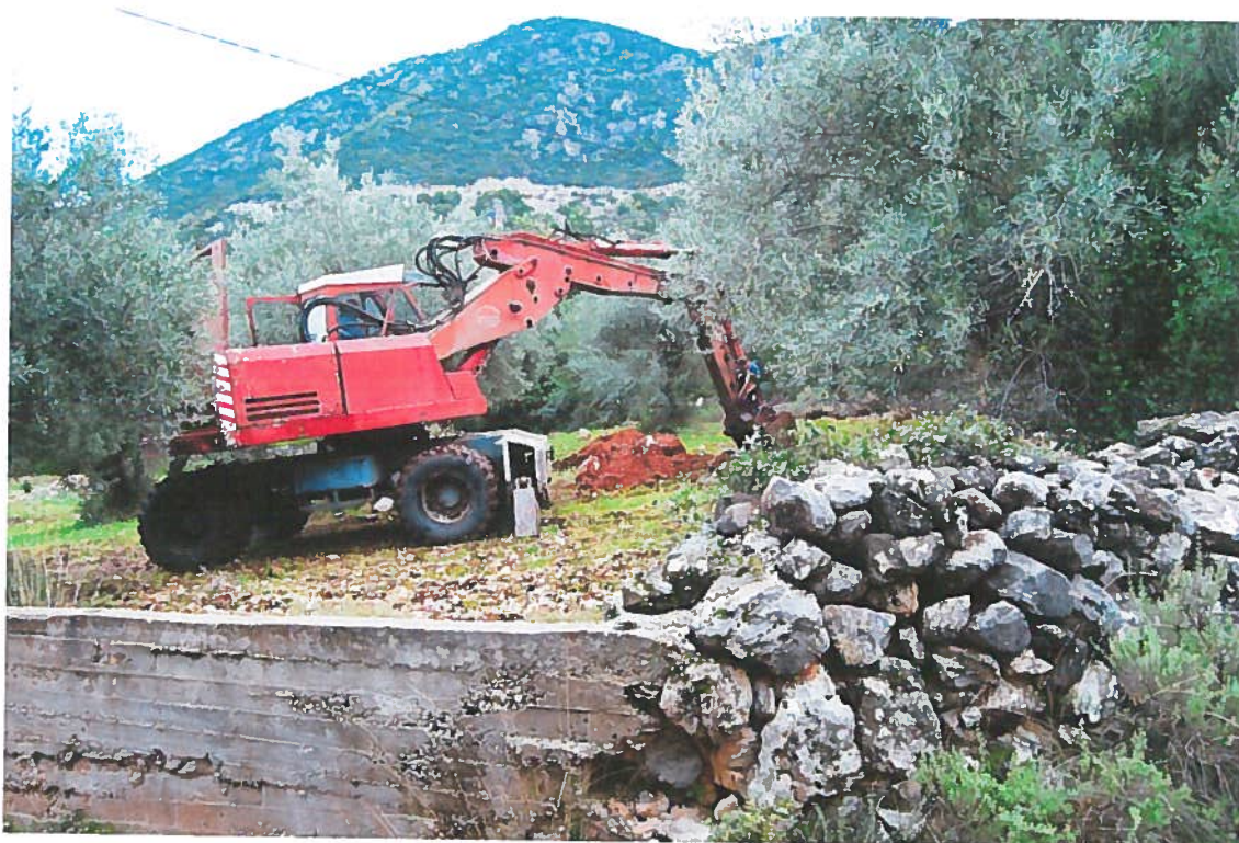
Φωτ.20. Δειγματοληπτικό φρέαρ ΕΦ3. Διακρίνεται τοίχιο και λιθοδομή αντιστήριξης του εδαφικού υλικού.
