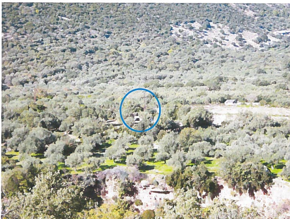
Φωτ.23. Άποψη περιοχής θεμελίωσης εγκαταστάσεων βιολογικού καθαρισμού. Στον κύκλο διακρίνεται το γεωτρύπανο στην θέση γεώτρησης Γ2.
