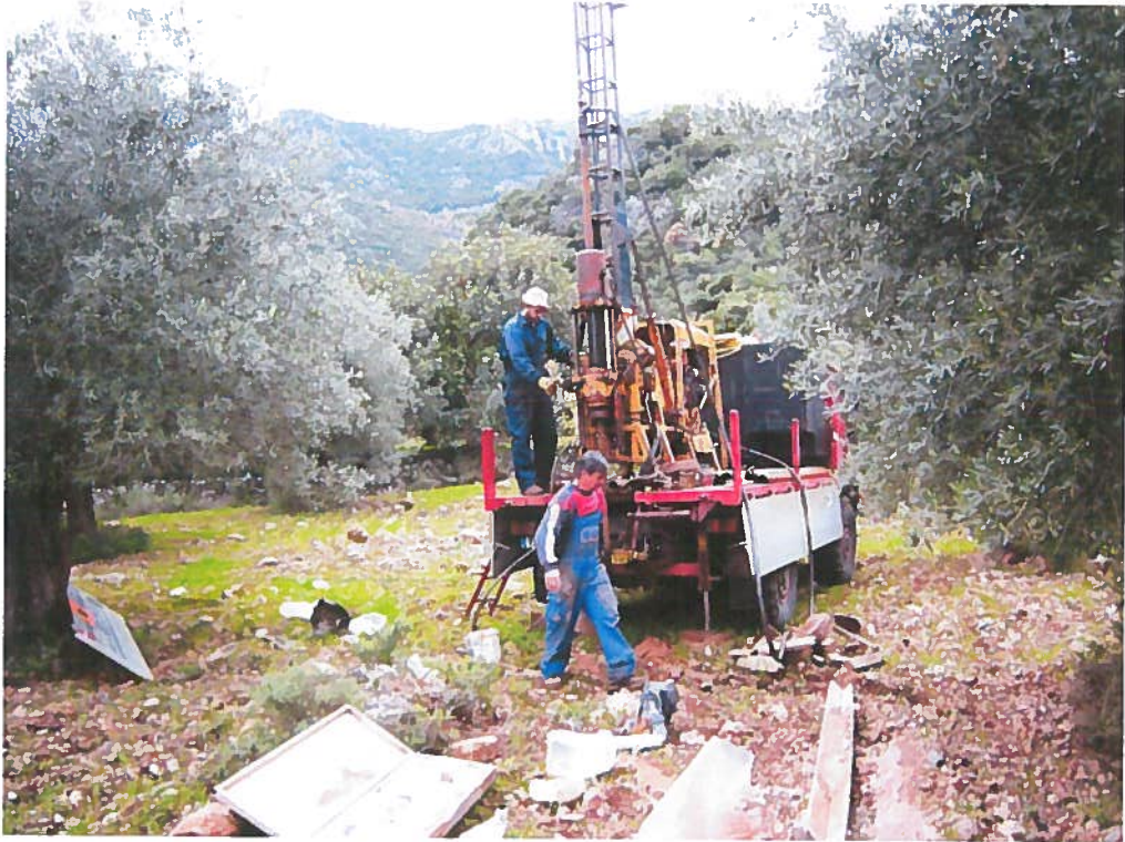
Φωτ.10. Θέση εκτέλεσης δειγματοληπτικής γεώτρησης Γ4.
